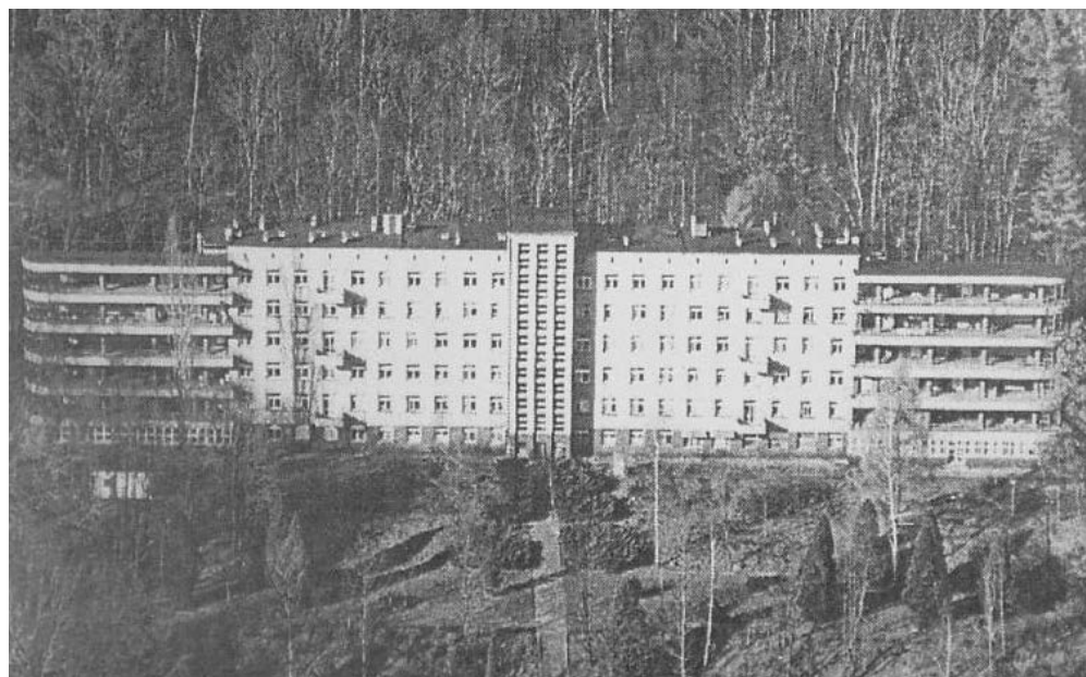
Zdjęcie 10. Sanatorium ZUS w Bystrej wzniesione w 1936 r.
