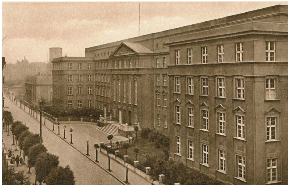
Zdjęcie 1. Budynek ZUS w Chorzowie
