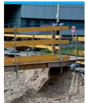
Przeście nad wykopem musi być zabezpieczone balustradami.
