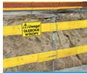
Zabezpieczenie krawędzi wykopu.
