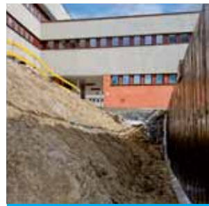
Bezpieczne nachylenie skarp wykopu.
