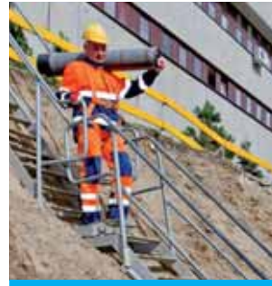
Bezpieczne zejście do wykopu.
